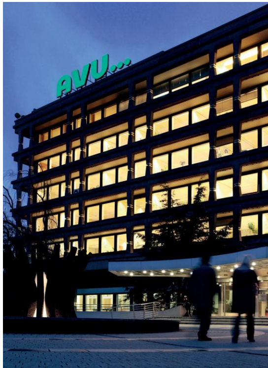
Die AVU sorgt für eine sichere Energieversorgung. FOTO: BERND HENKEL
